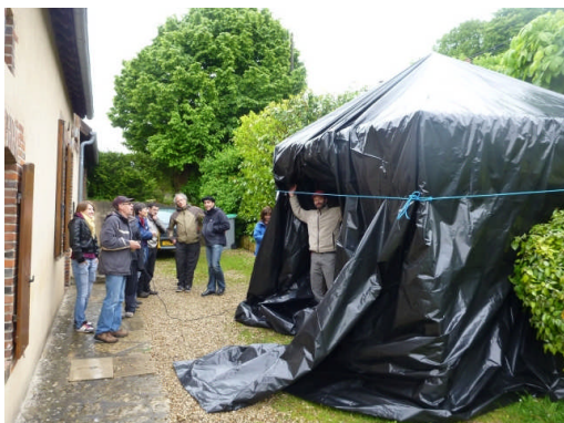
Le sas étanche au dessus de l'entrée du Puits Bouillant
